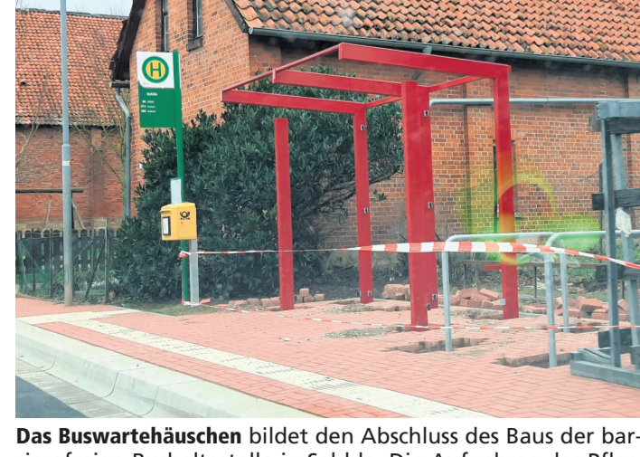
Das Buswartehäuschen bildet den Abschluss des Baus der barrierefreien Bushaltestelle in Sehlede. Die Aufnahme des Pflasters für den Einbau der Stahlkonstruktion habe sich bewährt.
