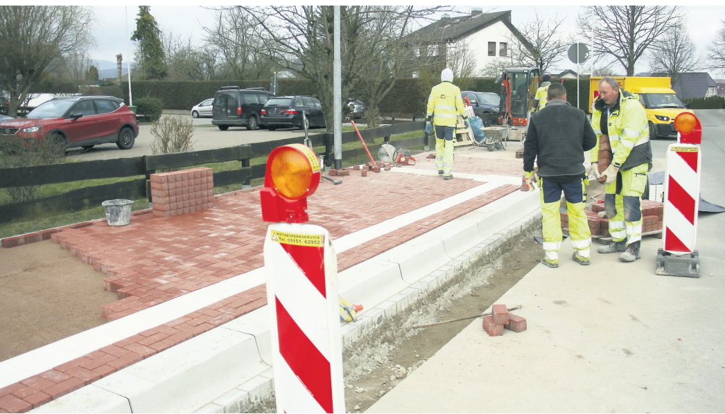
Fleißige Bauarbeiter im Einsatz: Bei dieser Bushaltestelle an der Louis-Krüger-Straße haben bereits die Pflasterarbeiten begonnen.
