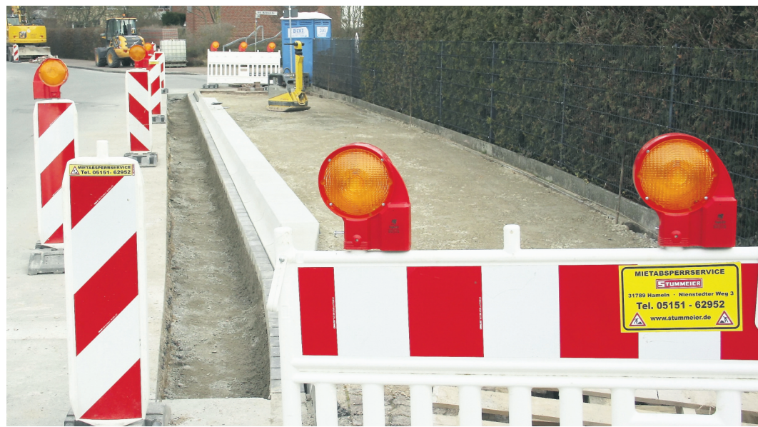
Diese Bushaltestelle wird auch barrierefrei gestaltet: Noch in diesen Tagen soll sie fertig sein. Damit ist der nächste Bauabschnitt in Elze erledigt.
